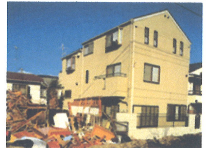
▲震度7の激震に耐えたツーバイフォー住宅(兵庫県南部地震)
