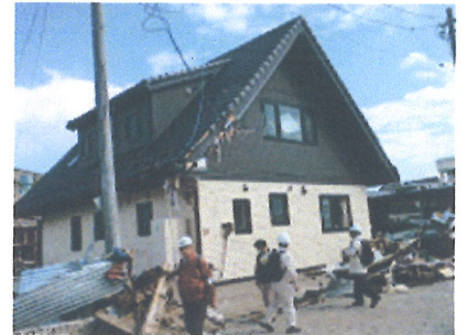
▲4mの津波に耐えたツーバイフォー住宅 (東北地方太平洋沖地震 石巻市)
