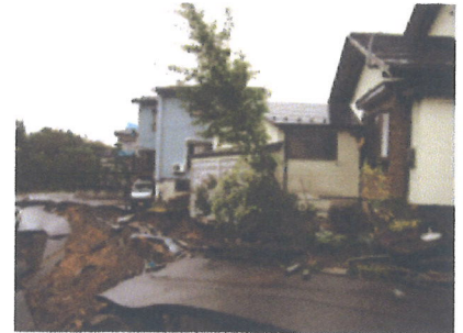
▲高町団地内の地盤崩壊(新潟県中越地震)
